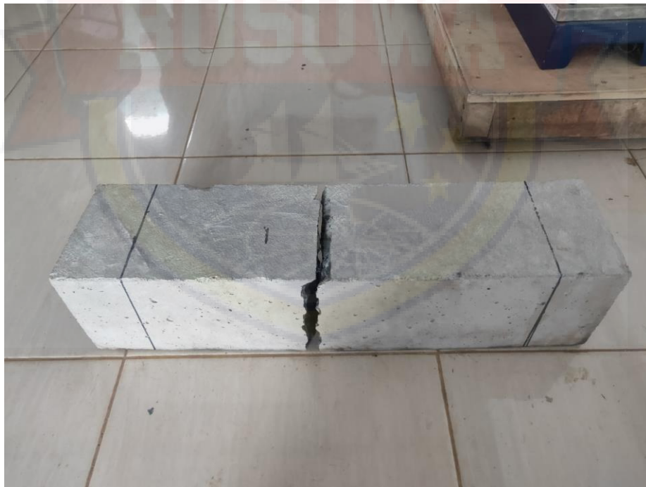
Gambar 20. Beton setelah Di uji Kuat lentur
