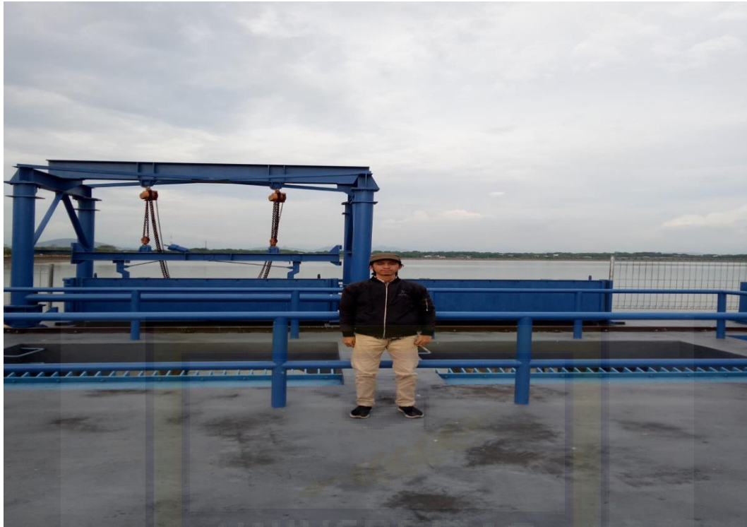
Stasiun pompa Kolam Regulasi Nipa-Nipa
