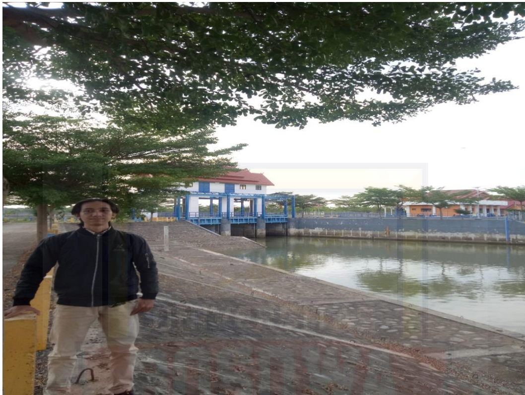
Sluiceway (pintu air masuk) Kolam Regulasi Nipa-Nipa
