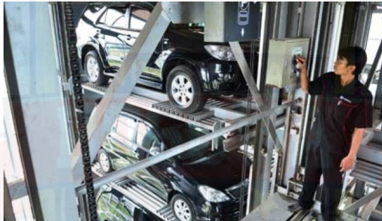
Gambar 2.20 Gedung Parkir Rumah Sakit Cipto Mangunkusumo (Sumber: Analisis Penulis. 2019)
