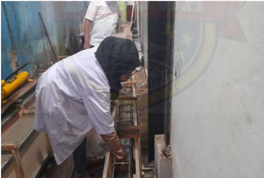
Gambar 2 Proses pembuatan balok beton
