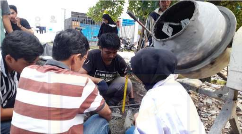
Gambar 1 Proses pembuatan balok beton
