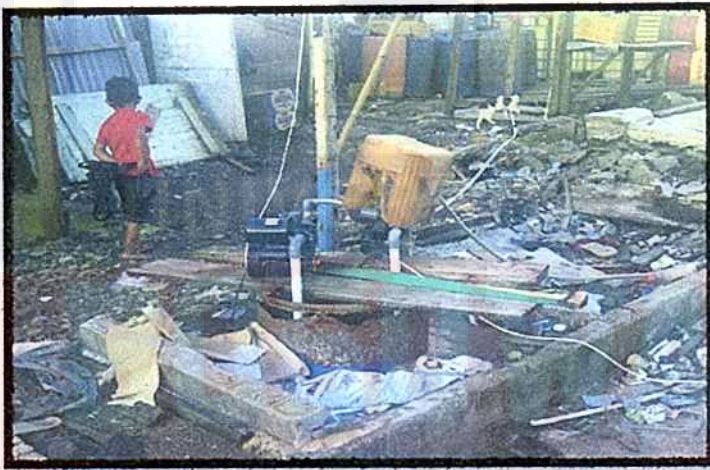
Gambar 4.11. Kondisi sumber air minum (PDAM)
