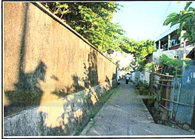
Gambar 4.8. Kondisi Jalan setapak yang ada dalam permukiman
