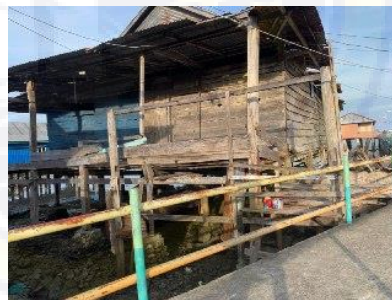
Gambar 5: Dokumentasi kondisi eksisting bangunan rumah di lokasi penelitian.
