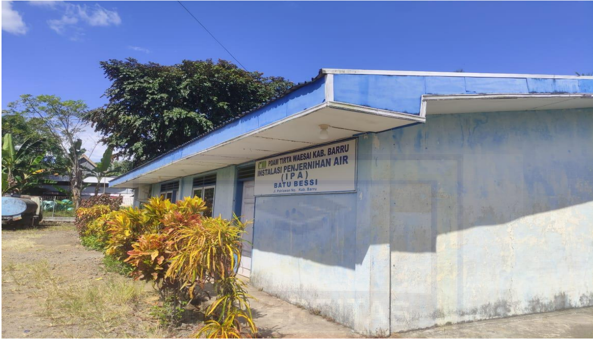
Dokumentasi 3. Lokasi Instalasi Pengolahan Air
