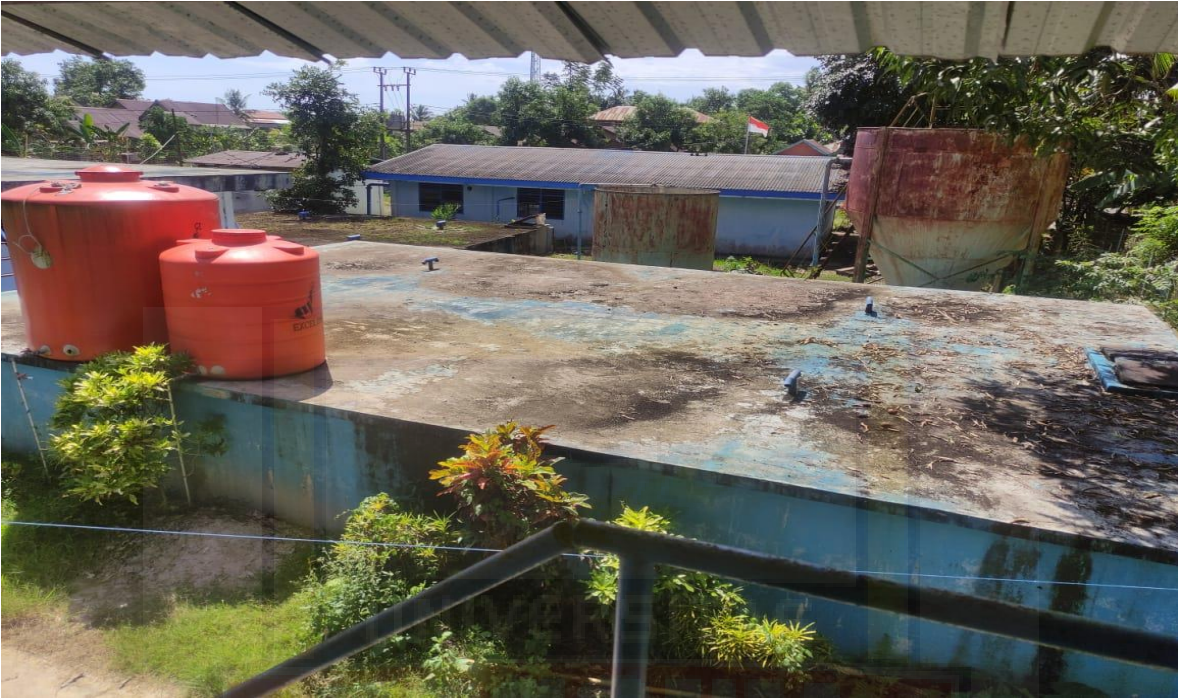
Dokumentasi 9. Reservoir (Kec.Balusu)
