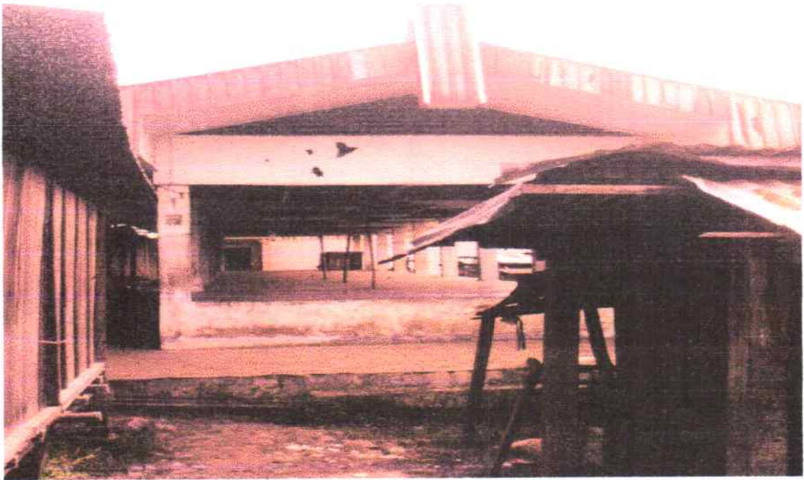
KONDISI PASAR TIDAK TERATUR
