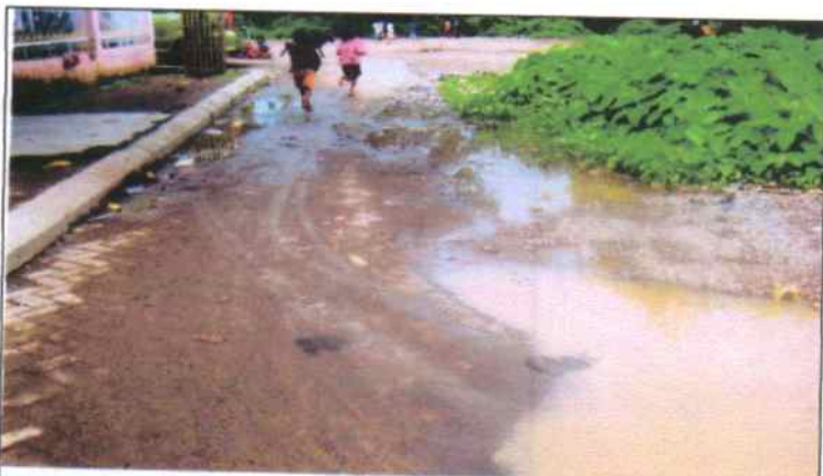
Kondisi jaringan jalan yang sudah mengalami perbaikan, tapi belum optimal, dan memerlukan penanganan
