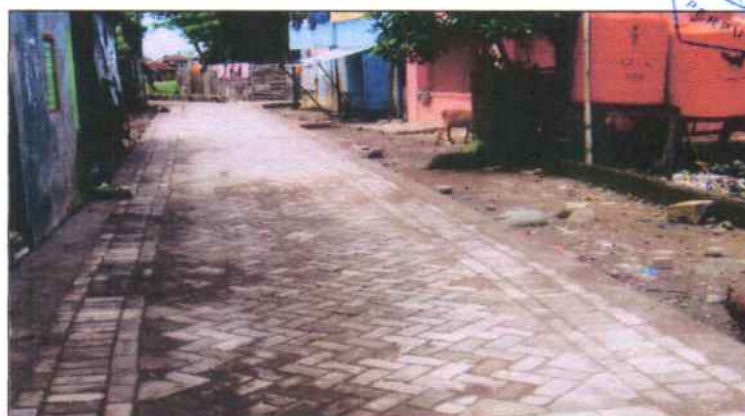
Kondisi jaringan jalan yang sudah mengalami perbaikan
