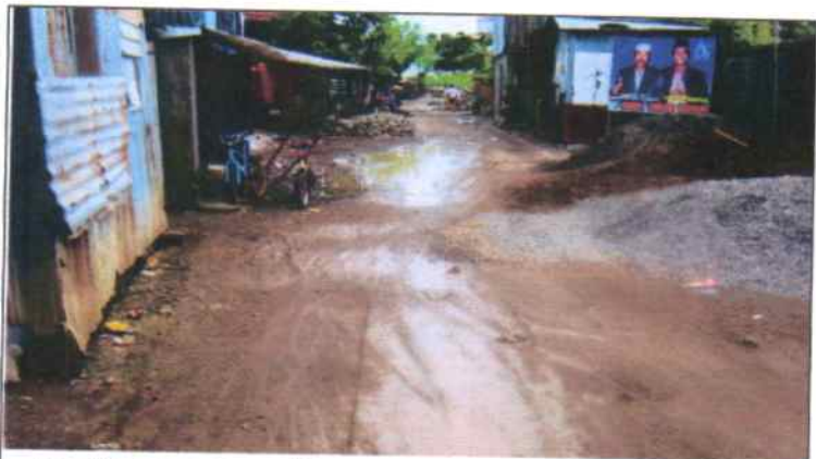
Lingkungan permukiman yang memerlukan penataan jaringan jalan
