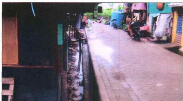
Lingkungan permukiman yang belum jaringan drainase
