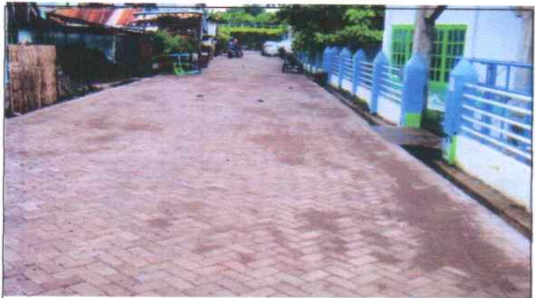
Kondisi jaringan jalan yang sudah mengalami perbaikan
