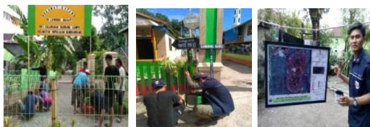
Pemasangan gerbang nama jalan Peta ADM
