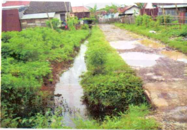
Gambar 07. Drainase sekunder dengan konstruksi tanah
