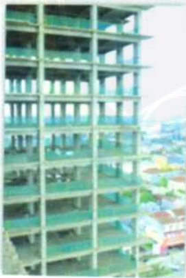
Dokumentasi Pemasangan Safety Net
