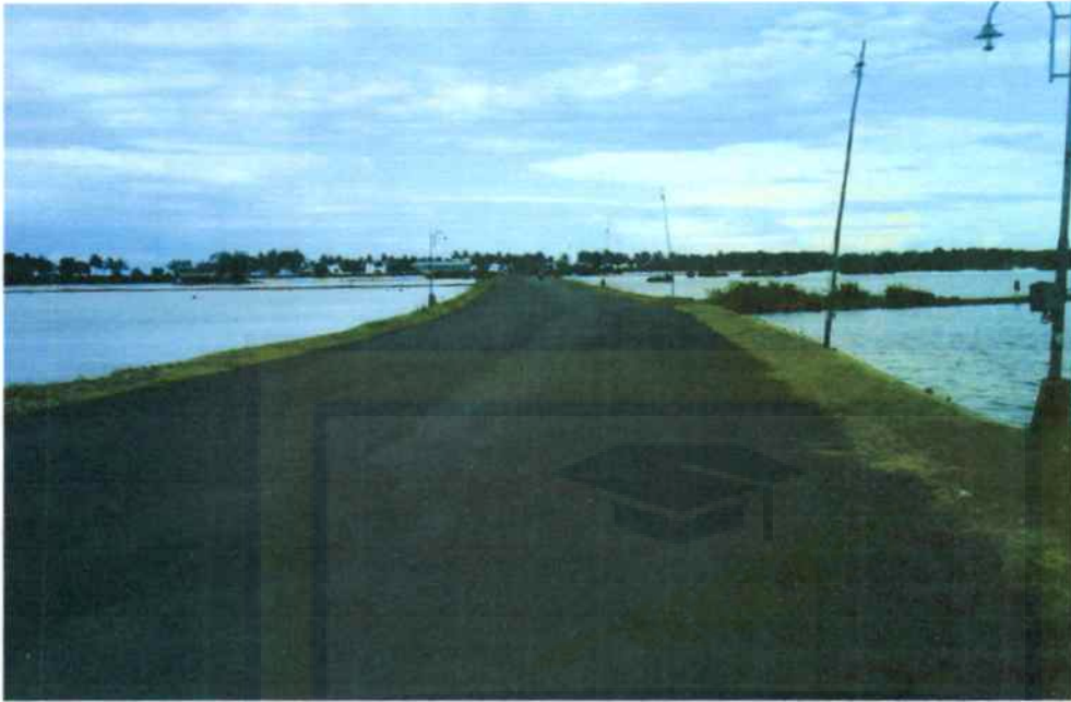
Foto Jalur Akses Menuju Pantai Labombo
