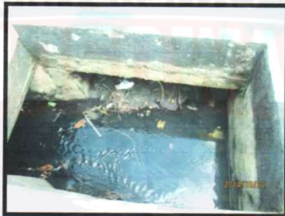
Gambar 4.8. Penumpukan sedimen didalam badan drainase sekunder
