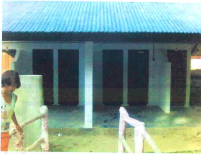
Gambar Toilet dan Kamar Ganti untuk pengunjung yang ingin berenang yang ada di Kawasan Hutan Jompie
