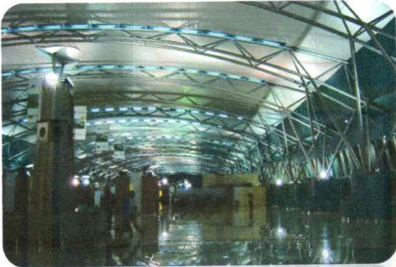
Gambar V.16. : Rangka ruang (space frame structures)
