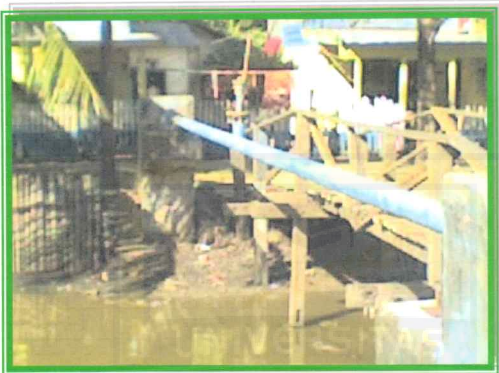
Jembatan di kawasan penelitian dengan konstruksi kayu yang melintasi kanal dikawasan penelitian
