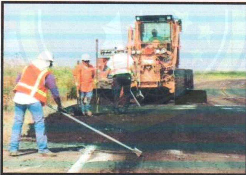
Gambar IV.20. Penghamparan lapisan permukaan
