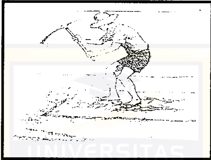
Gambar II.16. Penggalian jalan yang rusak dengan menggunakan blincong. Sumber : DPU, 1983
