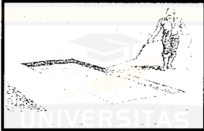
Gambar II.18. Penyiraman dengan tack coat Sumber : DPU, 1983
