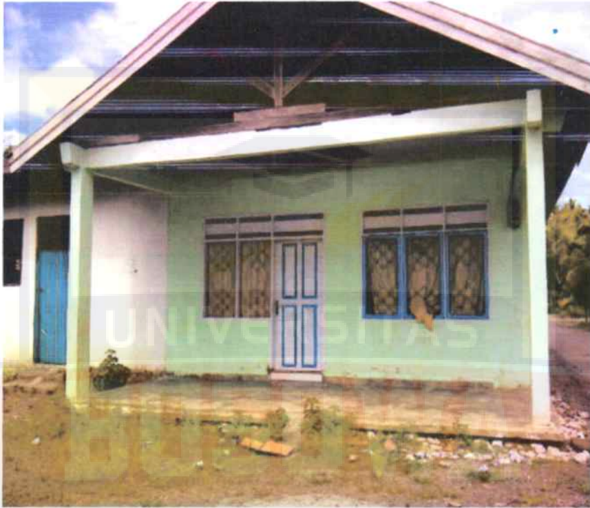
Gambar 1. Pembangunan Kantor desa yang menggunakan anggaran dana Bahteramas.
