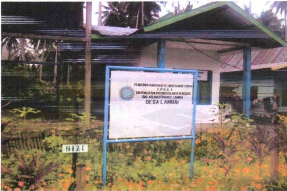
Gambar 5 : gambar pembangunan kantor PKK Kec : lambai
