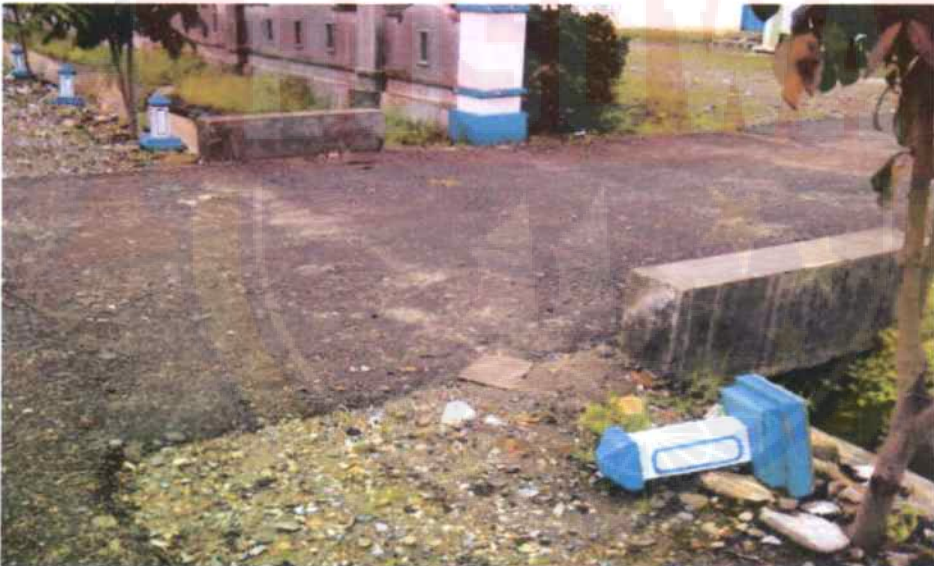
Gambar 6 : Pembangunan Deker yang menggunakan Dana Bahteramas
