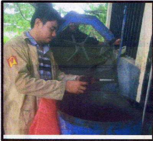
Penambahan Serat ijuk Kedalam campuran Beton
